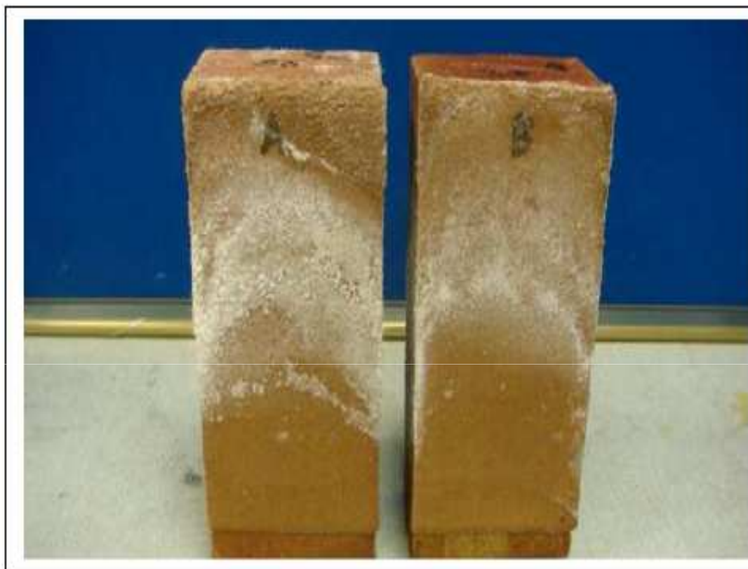
Fot.. 3: Krystalizacja soli na powierzchni ściany ceglanej pokrytej warstwą gipsowego tynku. Siła krystalizacji powoduje zniszczenie wewnętrznej struktury powłoki gipsowej, co skutkuje powstaniem nierównej powierzchni.
