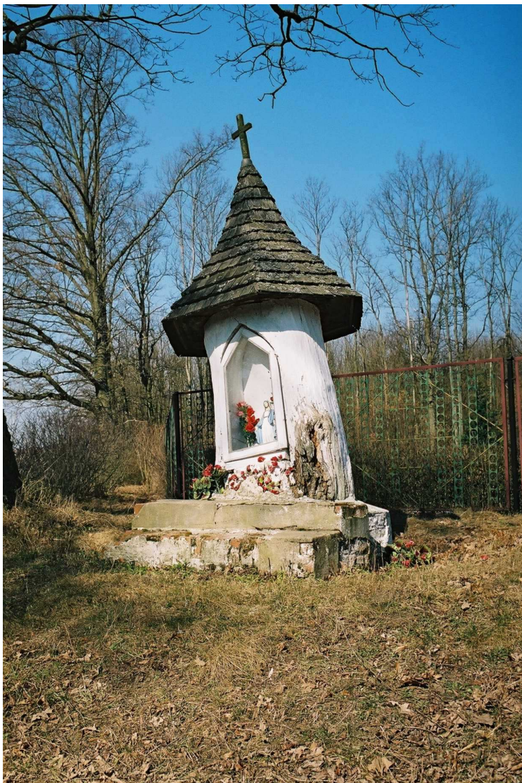
Obiekt małej architektury
